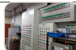
電源中控管理系統
