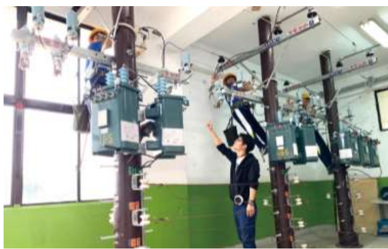
電機科電力維修課程
